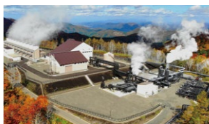
わさびざわ山葵沢地熱発電所
