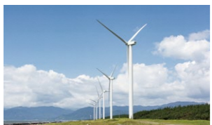
八峰町沿岸部の風力発電
